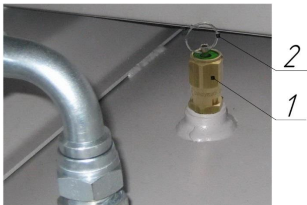
Рисунок 10 – Клапан предохранительный пружинного типа
