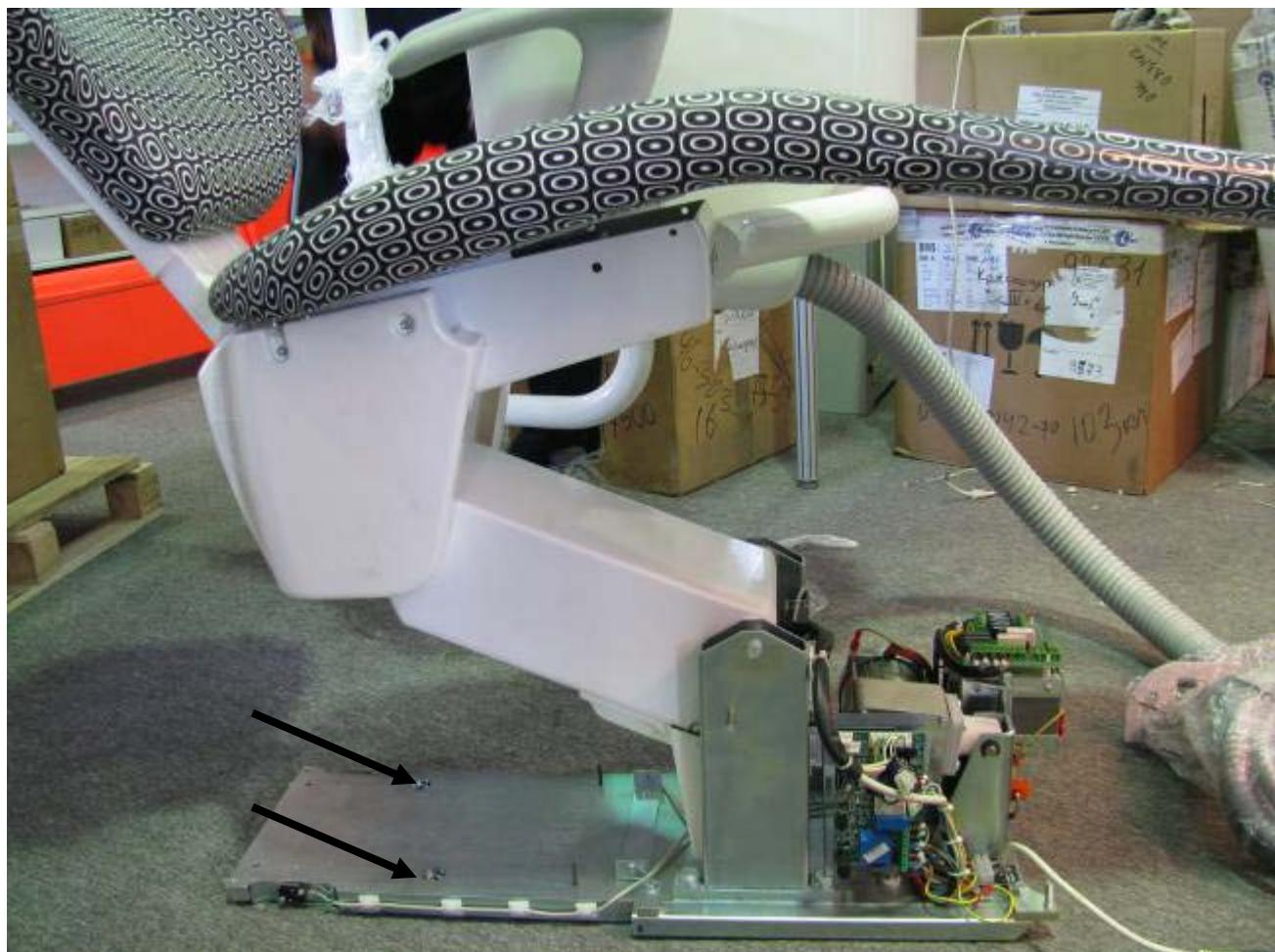
Отодвинув кресло просверлить в намеченных местах в полу 2 отверстия сверлом 12мм. Вставить в отверстия имеющиеся в комплекте дюбели, установить кресло на место и прикрепить его входящими в комплект шурупами.
